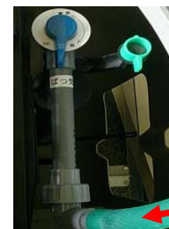
部材取付・水道水
