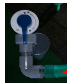
部材取付・水道水
